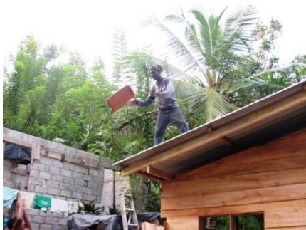
Die Firststeine werden gelegt
